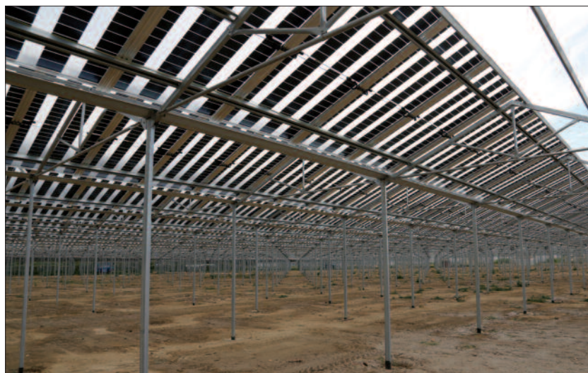
Serres damier photovoltaïques 35 % en construction Villeneuve de la Rivière (© T. Masdéu)
