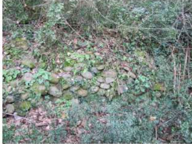
Des murs témoignent d'anciennes terrasses dans le coteau de la Nogarède
